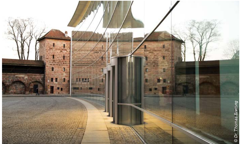
Außenansicht vom Neuen Museum Nürnberg
