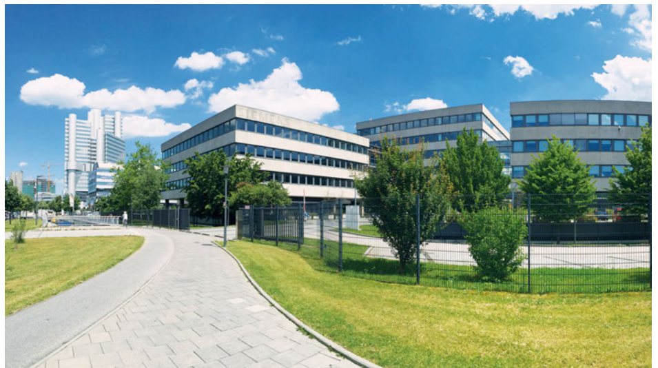
Die ehemaligen Siemens-Gebäude in München-Bogenhausen.
