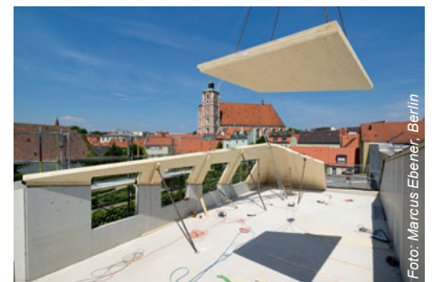
Aufbau der Dachkonstruktion im Mai 2015.
