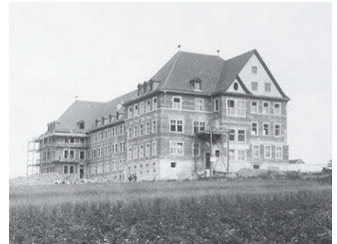
Abbildung 2: Das König-Ludwig-Haus 1916 in der späten Bauphase.
