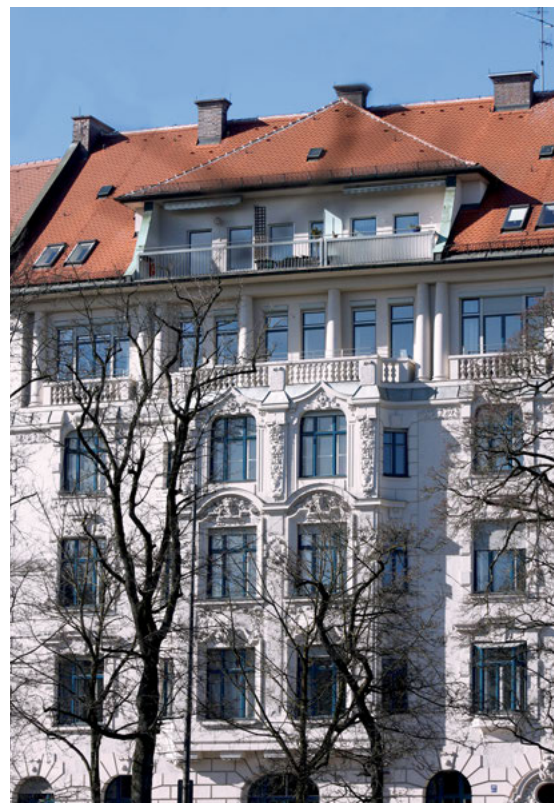
Die Verwaltung der Bayerischen Ärzteversorgung war zunächst im Münchner Stadtteil Lehel untergebracht. Die Immobilie aus dem Jahr 1902 dient noch heute als Vermietungsobjekt des Versorgungswerks.
