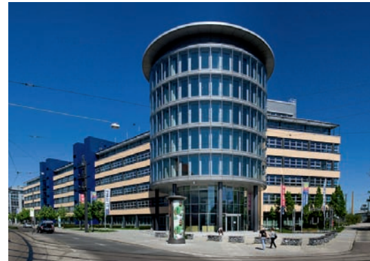
Die neuen Räume der Walner-Schulen am Ostbahnhof in München.
