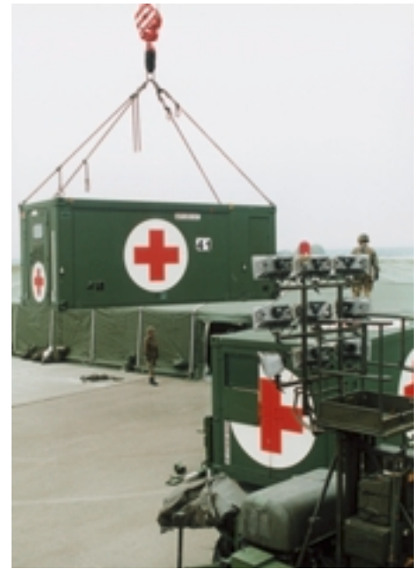
Positionieren eines 20-Fuß-Containers an ein Einheitszelt Typ II.
