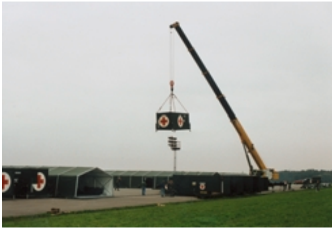
Aufbau und Positionierung eines 20-Fuß-Containers mit 120-t-Kran.
