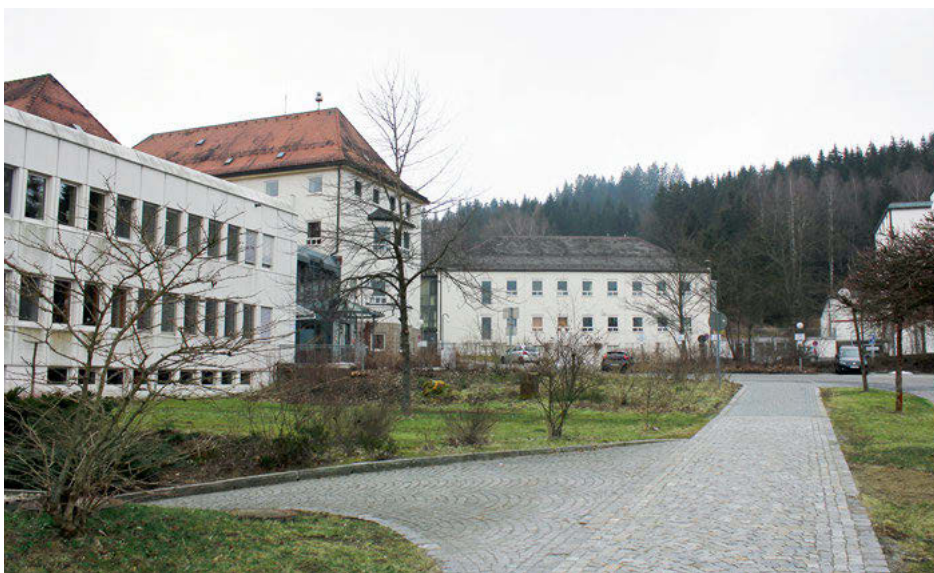
Das Kreiskrankenhaus in Zwiesel.
