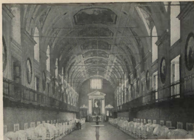
Abbildung 2 Neapel, Hospital „Maria des Friedens“ (Hospitalhalle in der von jedem Bett der Blick zum Altar gegeben ist)
