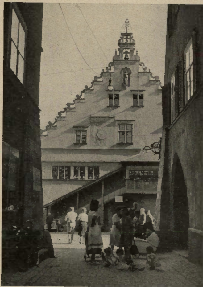
Nordseite des Alten Rathauses in Lindau
